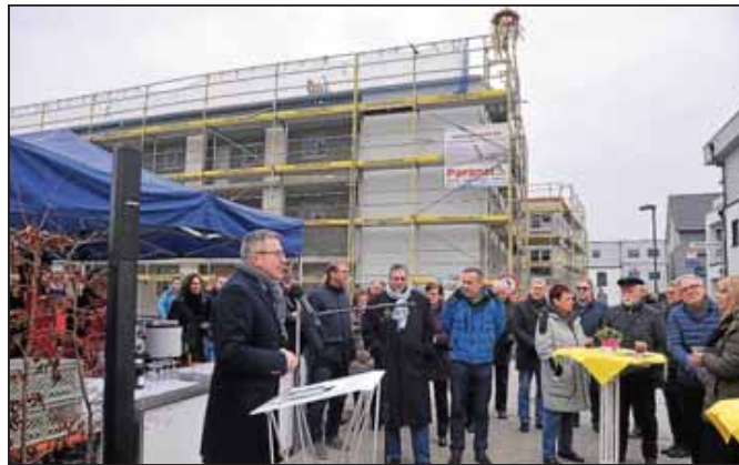
Das Carl-Orff-Quartier: Bald sind die 14 seniorengerechten Wohnungen hier fertig. Über die „terminliche Punktlandung“ freute sich FWD-Geschäftsführer Matthias Günther. Foto: Dorn
